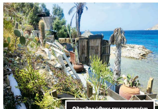
Ολοκληρώθηκε την περασμένη Δευτέρα η εξ ολοκλήρου κατεδάφιση σε beach bar στην Ελιά της Μυκόνου
